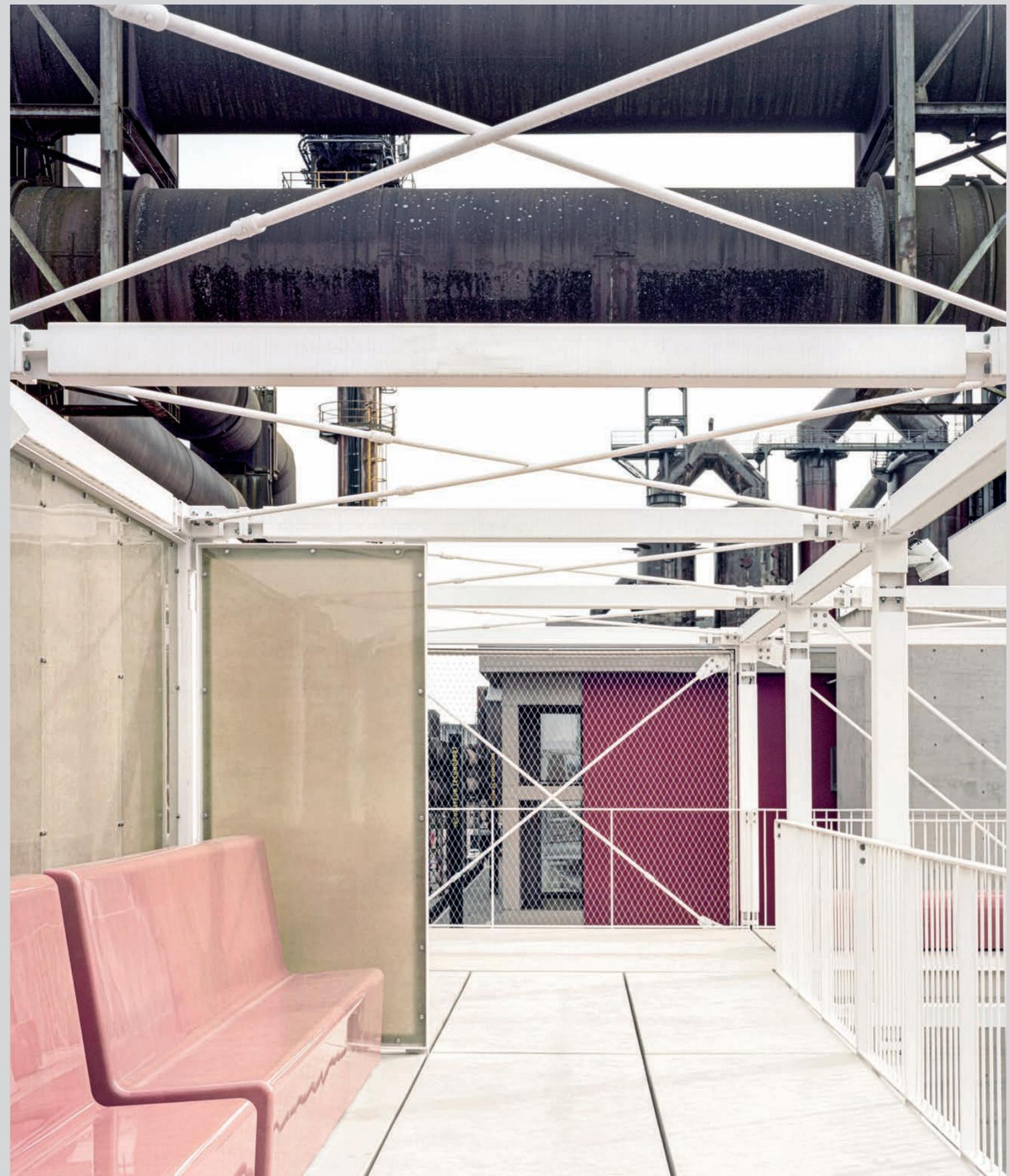
Die Geschossdecken sind aus vorgefertigten Betonplatten konstruiert. Die semitransparenten Paravents bestehen aus mit Kunstharz überzogenen Gitternetzen. Das Raumgitter ist nur teilweise ausgefacht, was den technisch-luftigen Charakter des Bauwerks verstärkt.
